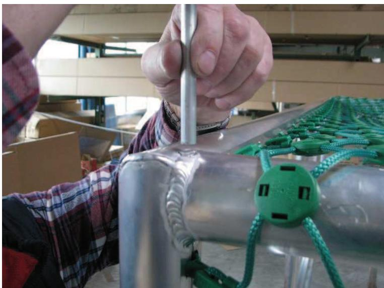
Mit den beiden letzten Stangen sichern Sie das Netz vor Diebstahl. Das letzte Ende der Stangen 9 + 10 geht durch die Spannung vom Netz etwas schwer mit der Hand. Bitte benutzen sie hier ein Stück Holz und einen Hammer.
